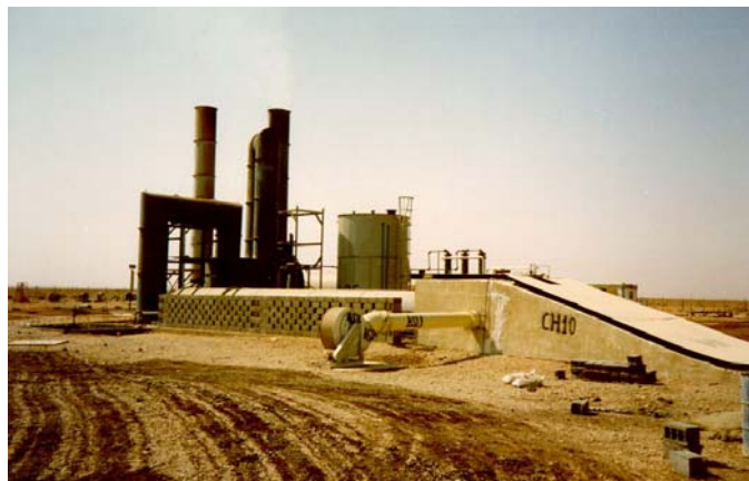
Anlage zur Vernichtung von Yperit
