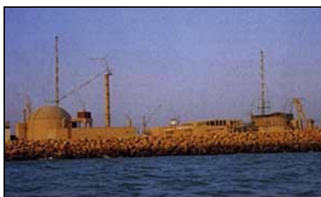
Figure 4 Le chantier du réacteur de Bushehr.
